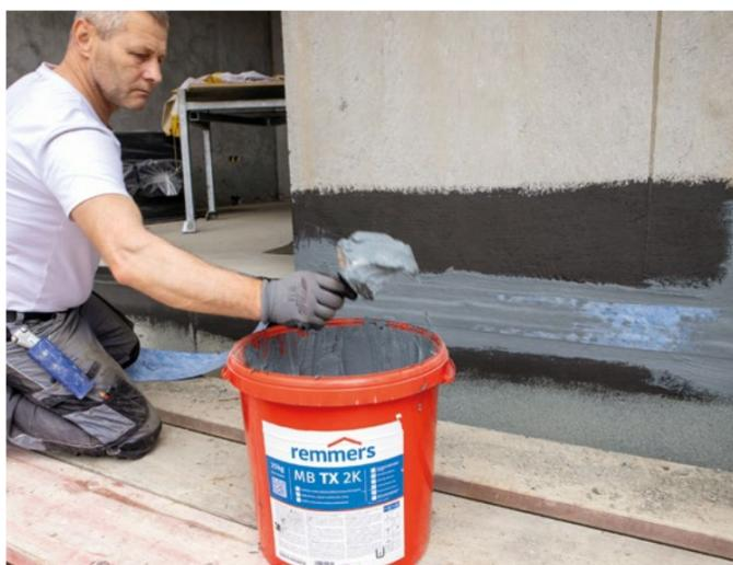
Die Abdichtung wurde mit der flexiblen polymermodifizierten Dickbeschichtung MB TX 2K ausgeführt.
